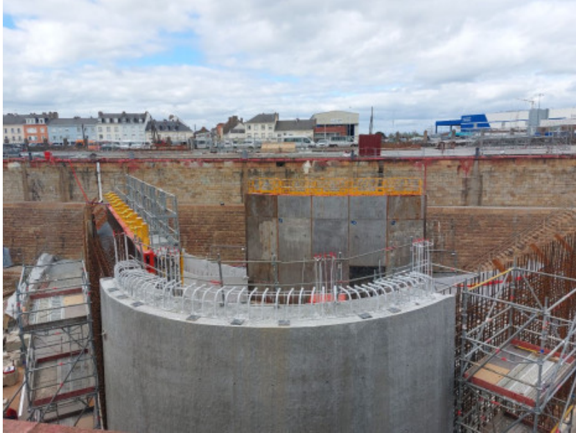
L'éperon en cours de construction, lors d'une visite du chantier des ouvrages de renforcement du fort Boyard, en avril 2026. © J.I. pour Batiactu
