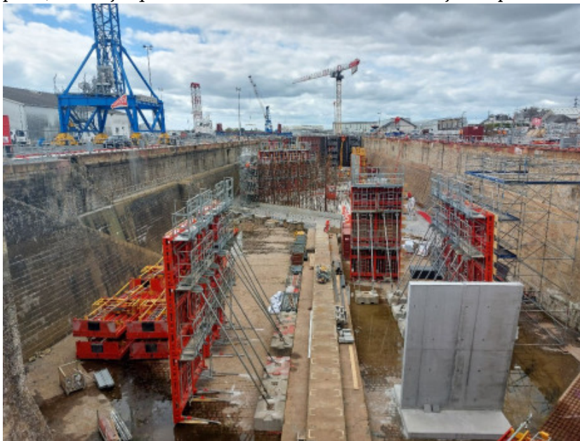
Visite du chantier des ouvrages de renforcement du fort Boyard, dans le port de Nantes - Saint-Nazaire. © J.I. pour Batiactu
