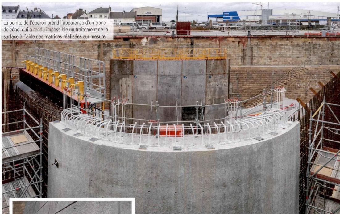
Le matriçage "Pierre" a été réalisé sur mesure à partir d'une empreinte prélevée sur la partie inférieure du fort.
